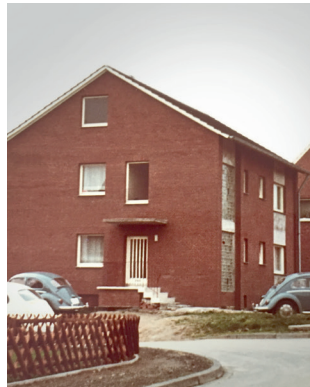
Der erste Firmensitz: Groenwold 12 in Schapdetten bei Münster The first company building: Groenwold 12 in Schapdetten near Münster
